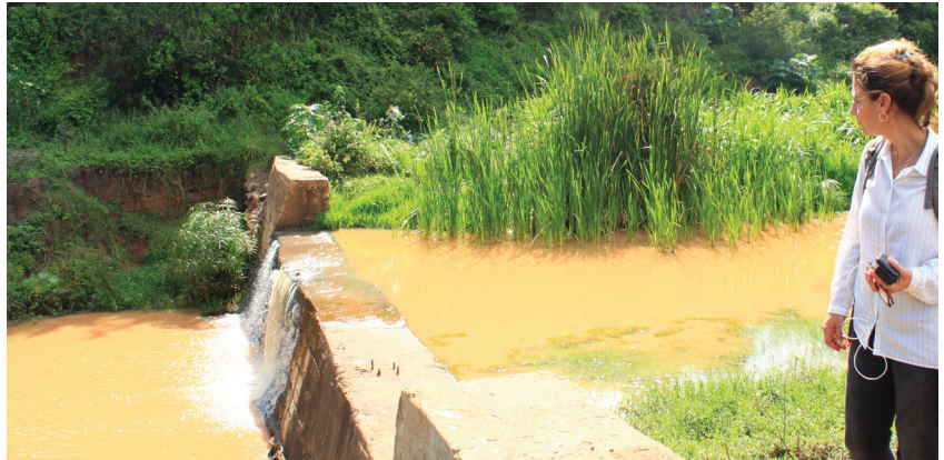
תמונה 3: סכר בטון שנבנה בערוץ נחל במואלה, על מנת לחסום הסעת חול ובכדי להשקיעו בערוץ הנחל. מים המסתננים דרך החול מנוצלים בעונה היבשה שיטת ה-SandDam. צילום: תמרה השמשוני
