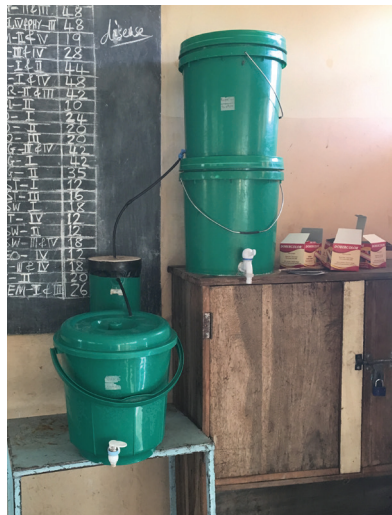
תמונה 7: מערכת סינון מים בבית ספר (מקור המים לא ידוע). במערכת מותקן פילטר bone char (הכלי בין שני הדליים עם האטימה שחורה). צילום: מיכל דולב השמשוני
